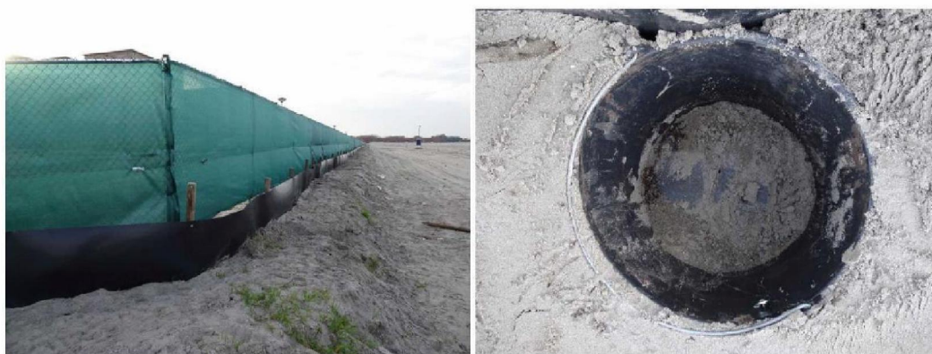
Figuur 4. Links het paddenscherm op het opgespoten formeel rugstreeppaddenvrije terrein en rechts één van de vele aanwezige valemers aan de binnenzijde van het paddenscherm.
