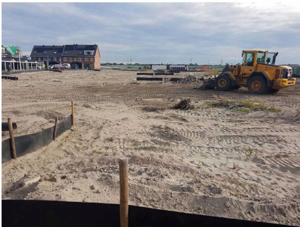
Figuur 2.1 Extra schermen en vangkruizen rond de bouwkaal voor de school.
