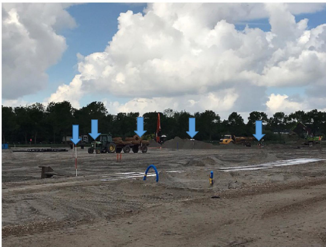
Afbeelding 2: blauwe pijlen geven de locaties van de slompaaltjes aan. Binnen deze paaltjes worden geen werkzaamheden uitgevoerd.
