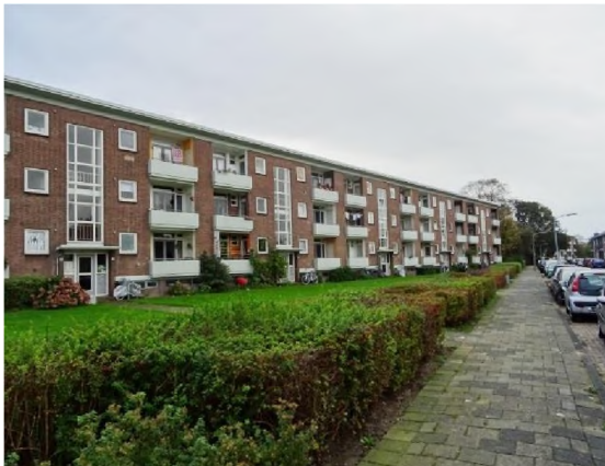
Aan de voorzijde van de woonblokken zijn geen bomen geplant.
