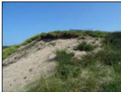
Figuur 32. Zicht op zuidelijk geëxposeerd zandig talud.
