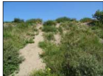
Figuur 33. Foto van noordelijk talud.
